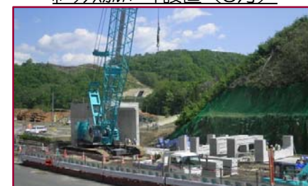
ボックスカルバート設置（5月）
