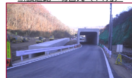
新設道路へ切替え（11月）
